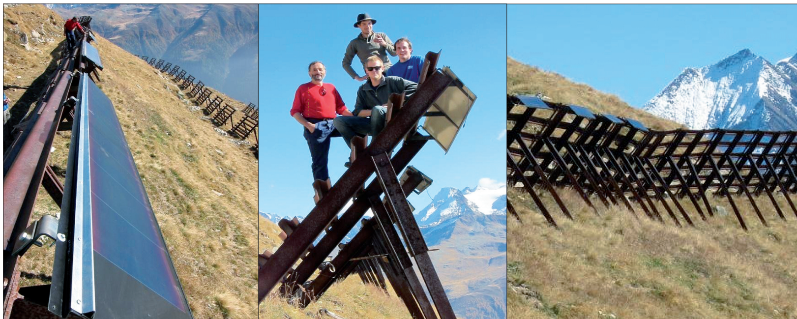
1) In Reih und Glied wurden die Solarpanels Ende Oktober 2010 entlang einer Lawinverbauung von Bellwald installiert. (2) Ruedi Lehmann (links), Dozent der Metallbautechnikschule Basel, gemeinsam zusammen mit einigen der Studenten bei der Installation. (3) Unauffällig sind die Panels der Sonne zugerichtet montiert.
